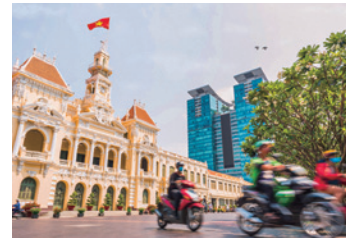
ホーチミン市庁舎
